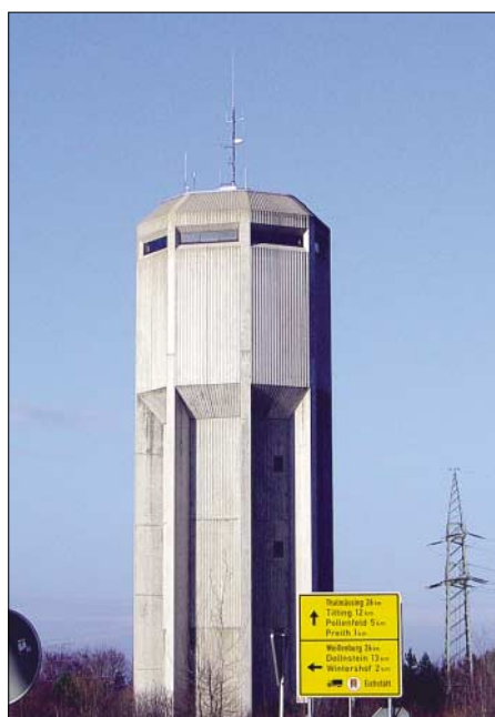
Der Wasserturm mit 45 m Höhe als idealer Standort für UHF. Links die Antenne von DB0EIC (439,175 MHz in JN58OV). Bei klarem Wetter sieht man bis zum Alpenhauptkamm. Fotos: DL3MGK
