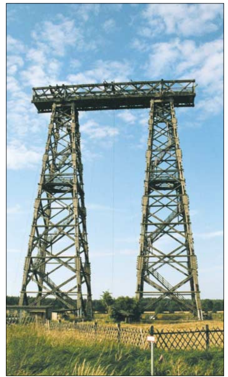
Die Spitzen des Zwillingturms (Messturm 3) verbindet ein 35 m langer und 5 m breiter Querträger. Foto: H. Lutz
